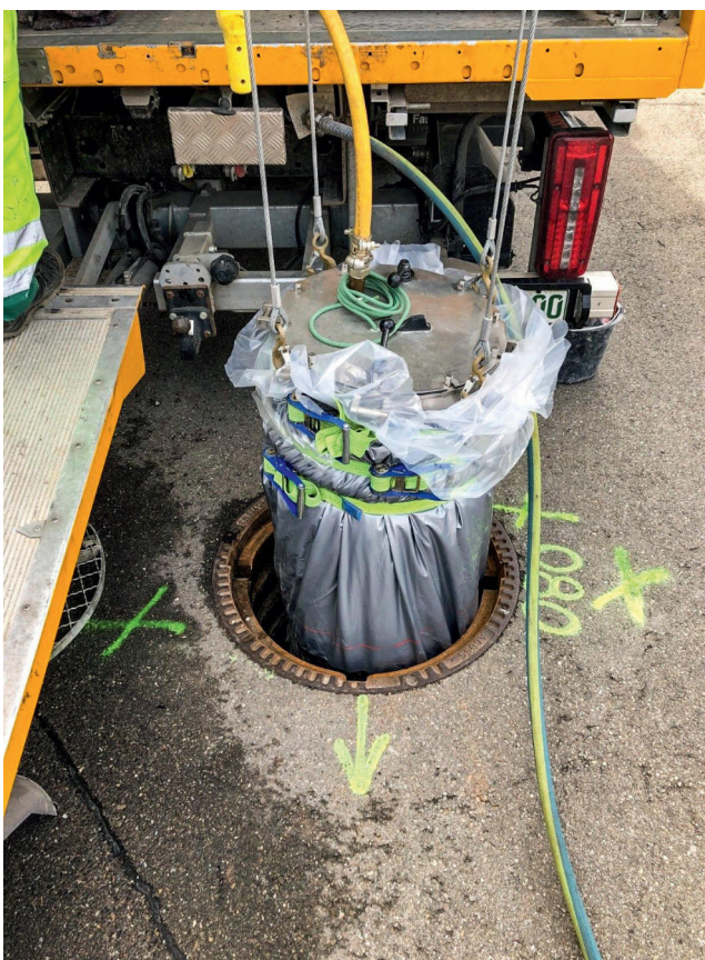
Schachtlinereinbau im Regelschacht DN 1000 | Fotos: Archiv ISAS GmbH
