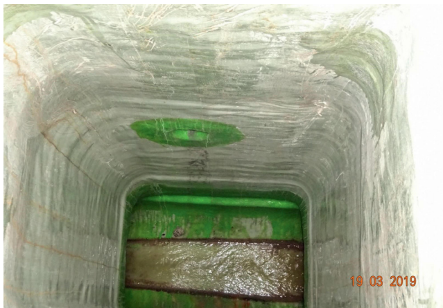
Fertiger Schachtliner im Rechteckschacht 1.000 x 1.000 mm
