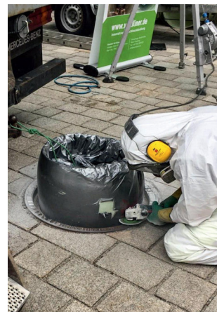
Zurechtschneiden des Schachtliners
