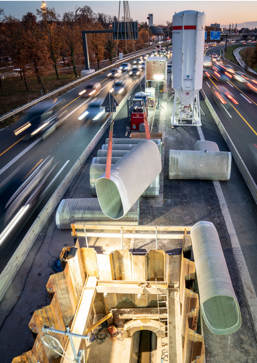
Sanierung eines Abwasserkanals unter der Autobahn bei Erlangen.
