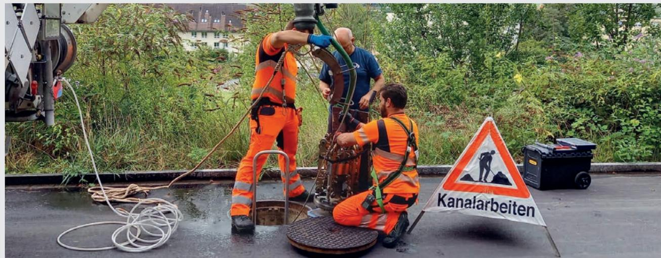
Bild 1 Kanalreinigung: Alles eine Frage der Düse und des Drucks? Antworten finden sich im neuen RSV-Merkblatt 12.1
